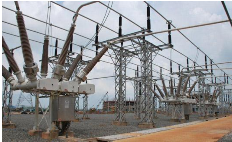
شکل (۱-۴۱): یک نمونه پست هیبریدی PASS
