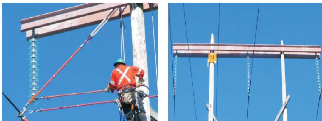
شکل (۱-۱۲): نمایی از کراس‌آرم کامپوزیتی
