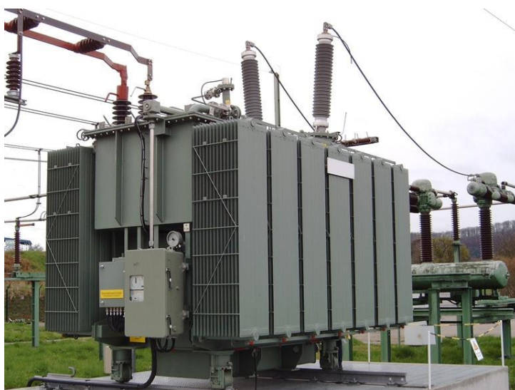
شکل (۱-۲۹): نمونه‌ای از یک ترانسفورماتور آب‌بندی شده بصورت هرمتیک
