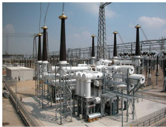
شکل (۳۳-۱): پست GIS به صورت روباز
