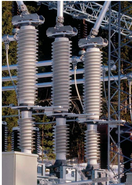
شکل (۱-۱۸): نمونه‌ای از مقره توخالی کامپوزیتی مورد استفاده در کلید قدرت
