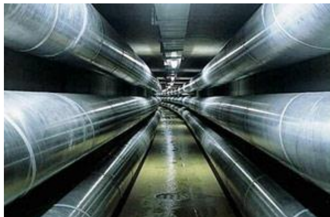
شکل (۱-۴۰): مجموعه‌ای از خطوط GIL عبوری از یک تونل
