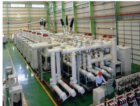
شکل (۳۴-۱): پست GIS به صورت سرپوشیده
