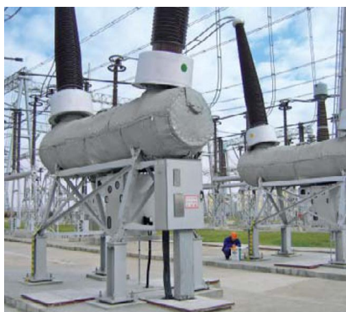
شکل (۱-۳۷): کلید قدرت نمونه‌ای برای مناطق سرد دارای تانک هیتر
